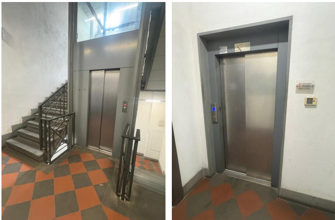
Figura 6 – Ascensore principale e montacarichi di tipo ascensore
