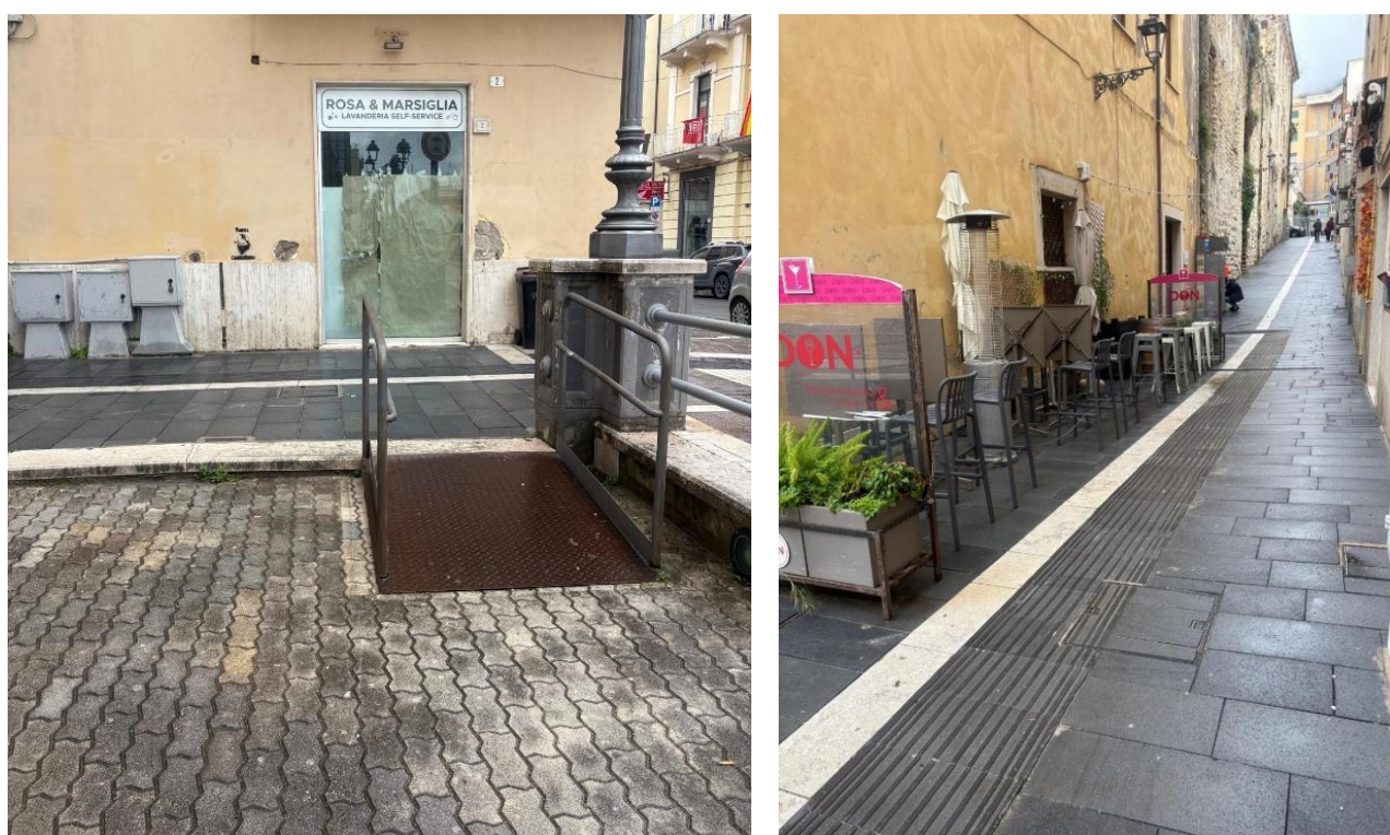
Figura 4 – Rampa di accesso all'ingresso principale e percorso a rilievo per non vedenti
