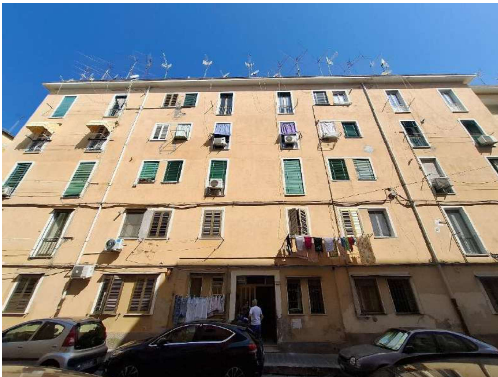
Foto 1 – Fabbricato oggetto di installazione impianto radiante
