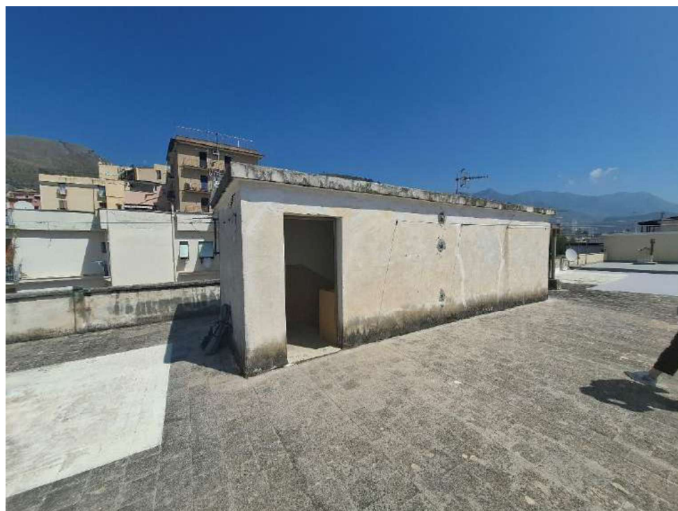
Foto 2 – Torrino oggetto di installazione impianto radiante
