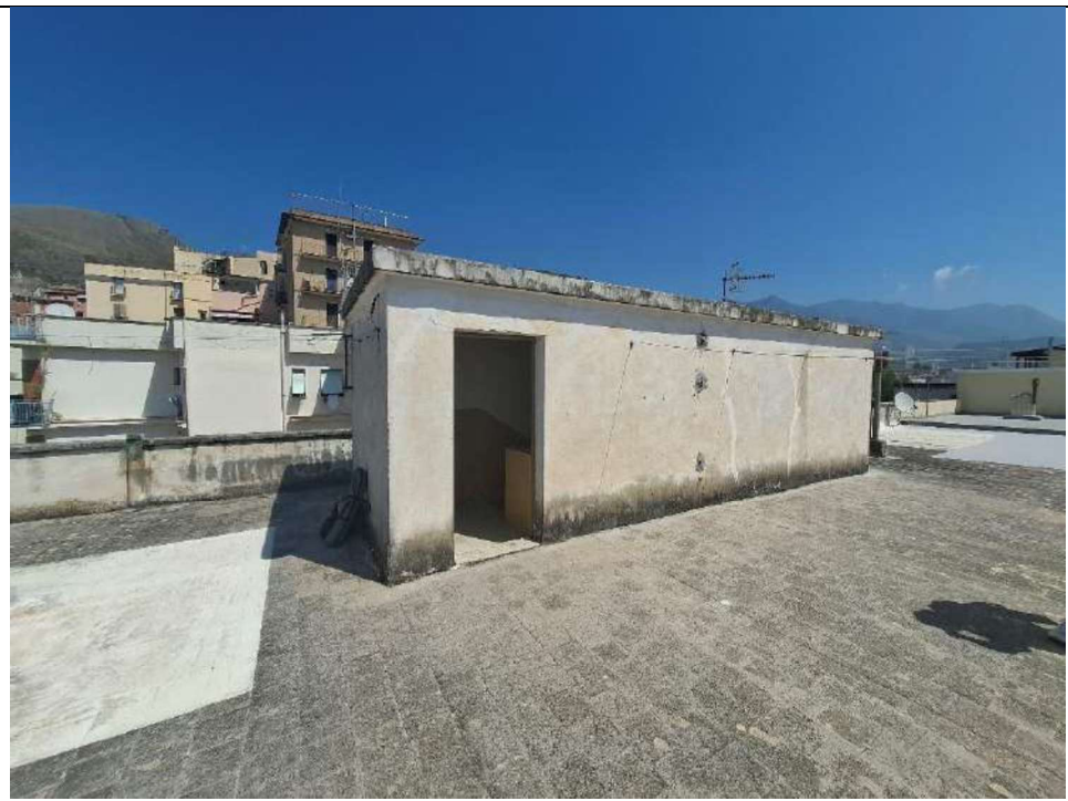
FOTO 1 – VISTA AREA INSTALLAZIONE SRB
